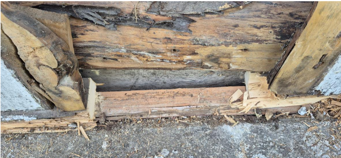
Bilde 22 Bilde av vannbrett hvor det var fuktskade og hvor en ser at trevirke utover skaden er av god kvalitet og at det er lite fukt og tørt på underliggende utlekting.
