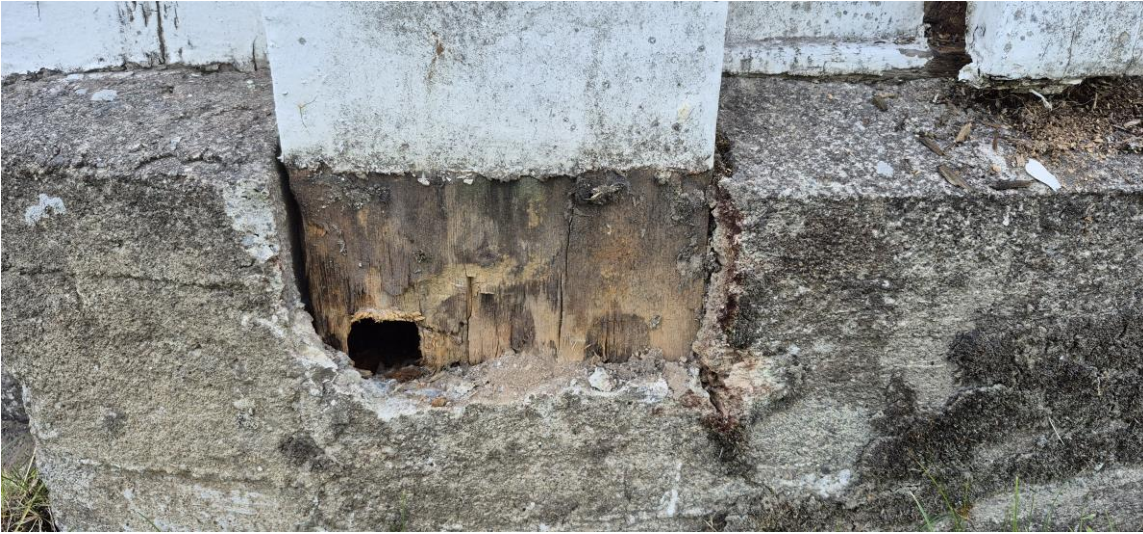
Bilde 23 Utkassing på nordveggen i overgang mot øst hvor det er råte i utkassing og i bakenforliggende bunnstokk
