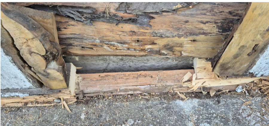
Bilde 8 Nærbilde av vannbrett som viser råde i ytre del mer fast innunder kledning og i bakkant
