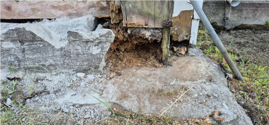
Bilde 9 Bilde viser lafteknute og utkassing i øvre hjørne på kyrkja på Nord veggen
