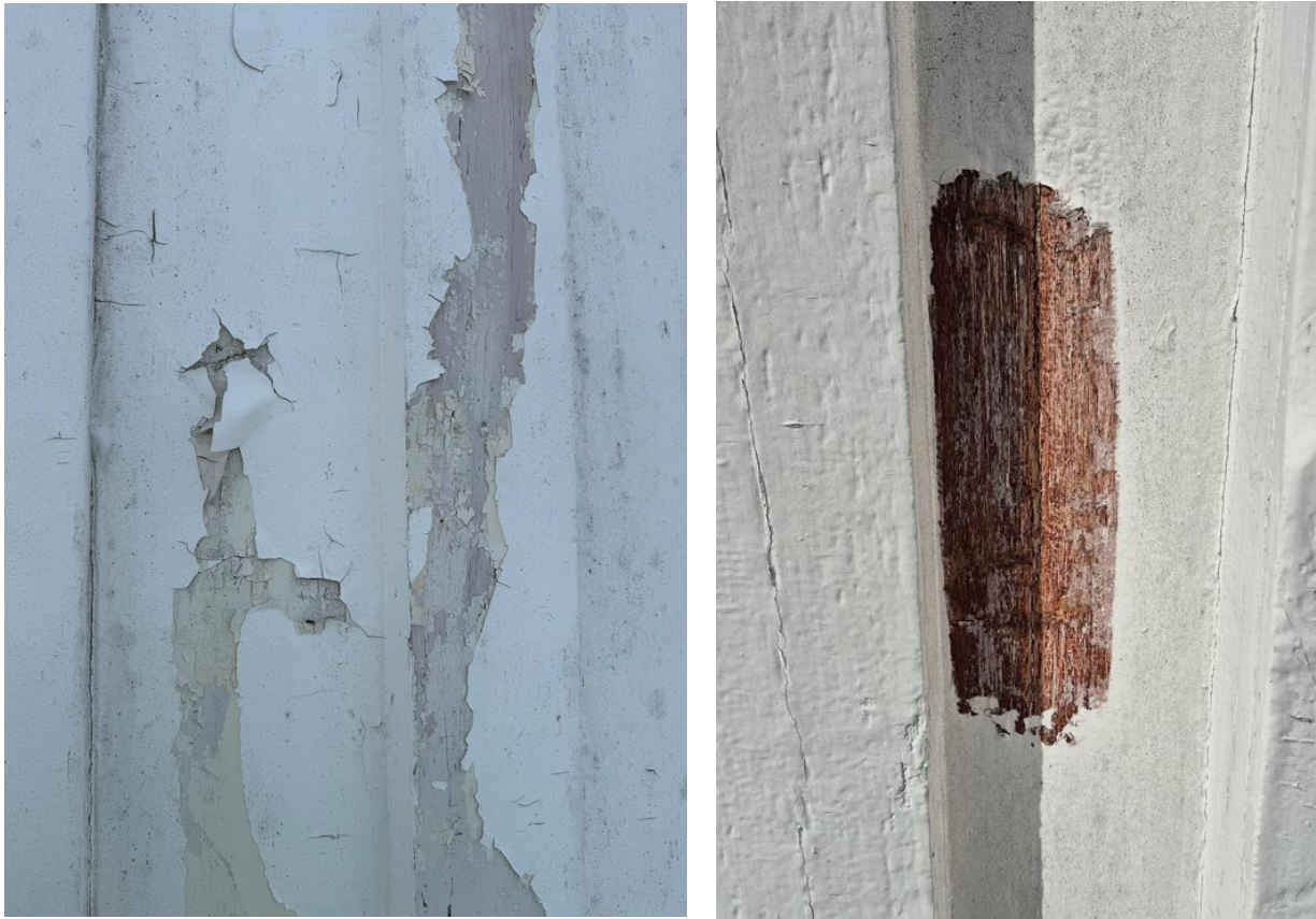
Bilde 13 Bilder som viser sprø malingslag og panelet under den slitte overflaten
