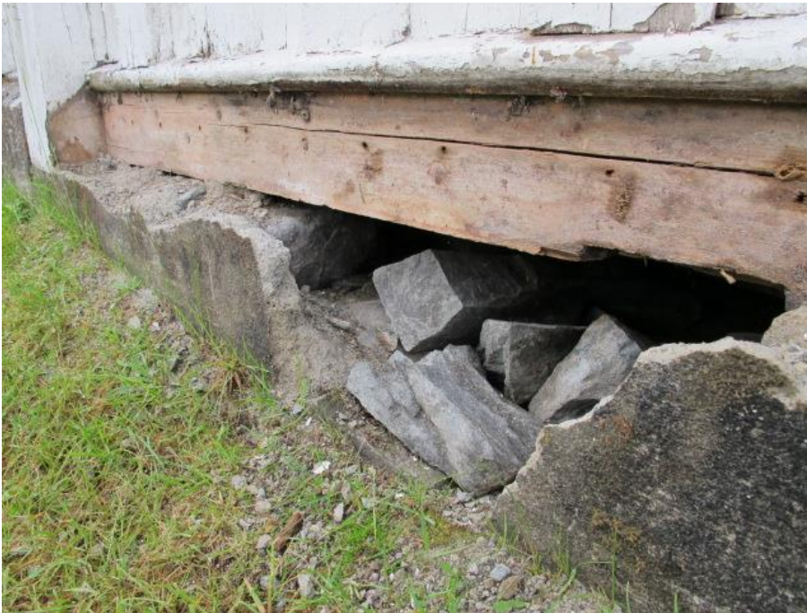
Bilde 11 Bilde hentet fra område hvor det ble pigget vekk for kartlegging av ringmur og underkant av laft på Nord veggen
