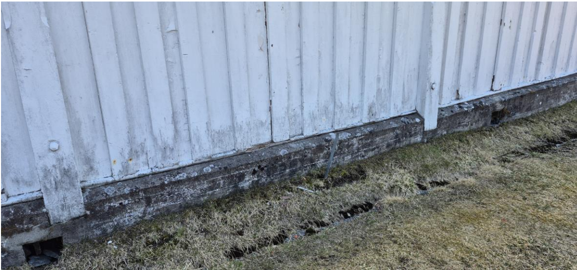
Bilde 21 Bilde av kledning og vannbrett hvor en ser fuktskade
