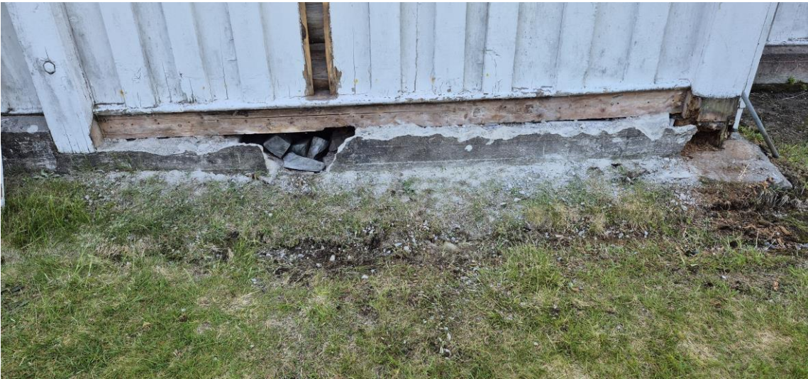
Bilde 19 Etter fjerning av betong hvor utlekting under vannbrett kommer synlig fram.
