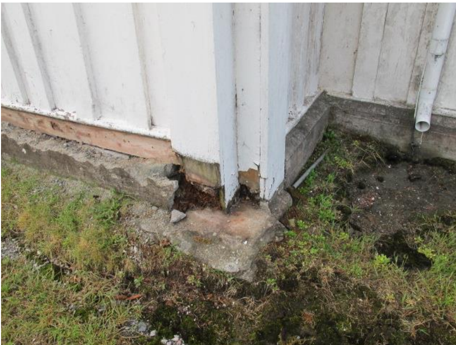
Bilde 12 Bilde fra øvre holdestein og utkassing rundt lafteknuter på Nord veggen
