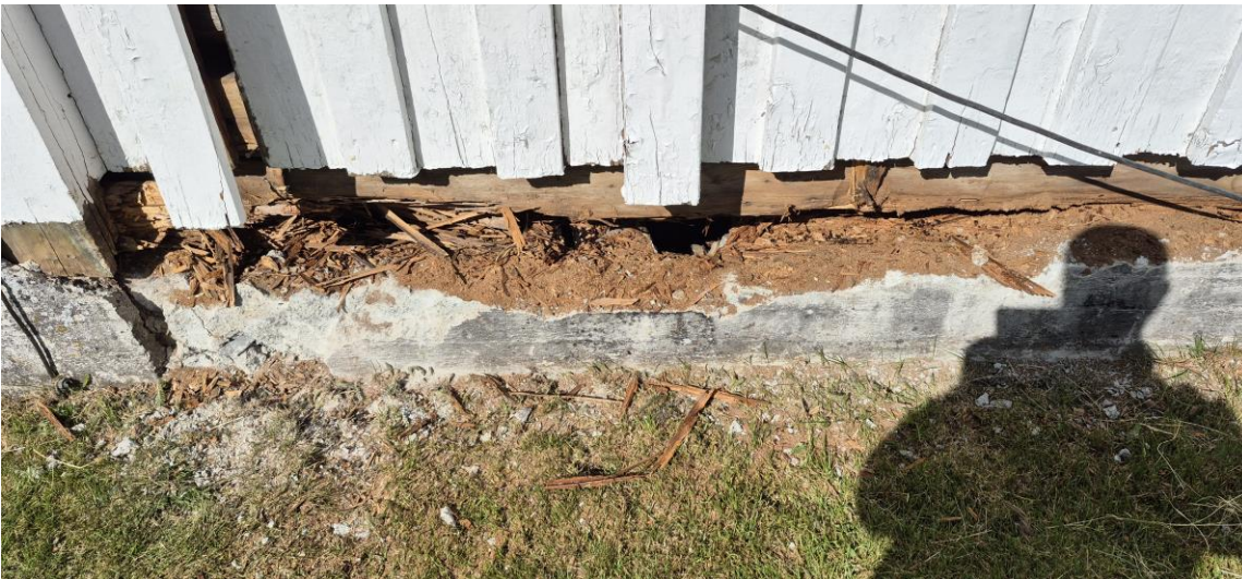
Bilde 16 Endevegg etter fjerning av betong hvor en ser angrepet fra maur.
