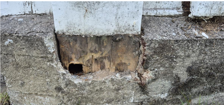
Bilde 10 Utkassing ved lafteknute på Nord veggen i overgang kirkerommet og prekestolen.
