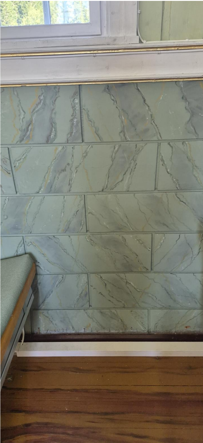
Bilde 14 Bilde fra innvendig side av Nord veggen øvre del mot prekestolen. En ser skade i nedre del av panelet brystningen og kanal for el til ovner montert under benkerekkene.
